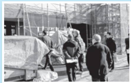
▲工事中のビジターセンター
