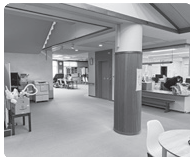
▲改修される福祉センター
