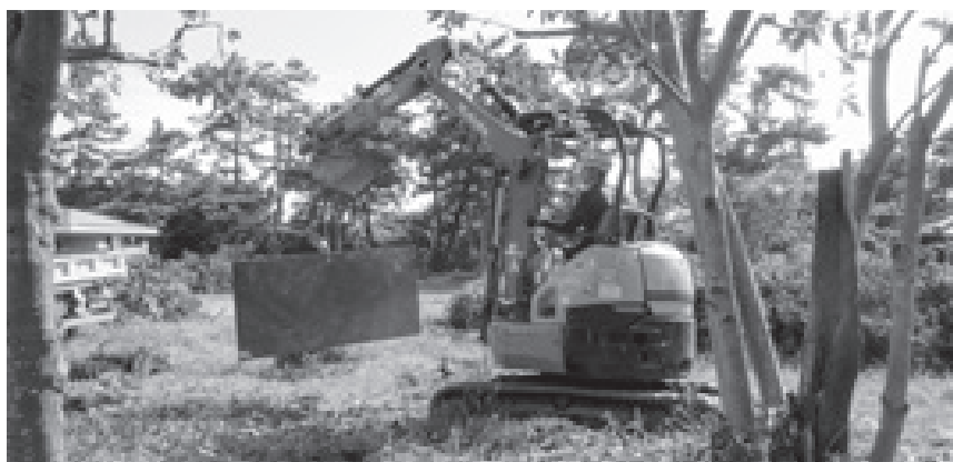
▲いよいよ1期工事スタート
