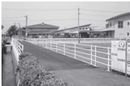
▲完成した歩道
