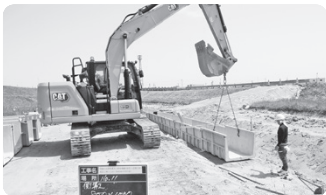
▲大型フリーフォーム水路設置状況
