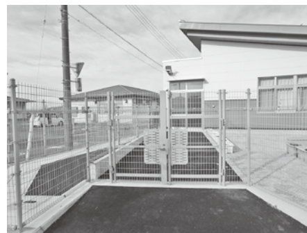
▲南側フェンス
