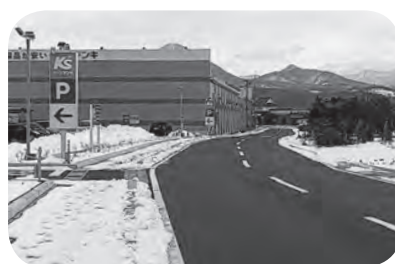
▲新しく整備された区画道路
