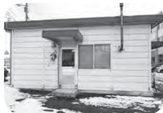
▲解体新築予定の陶芸作業所兼倉庫
