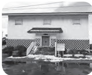
▲解体予定の民俗資料館
