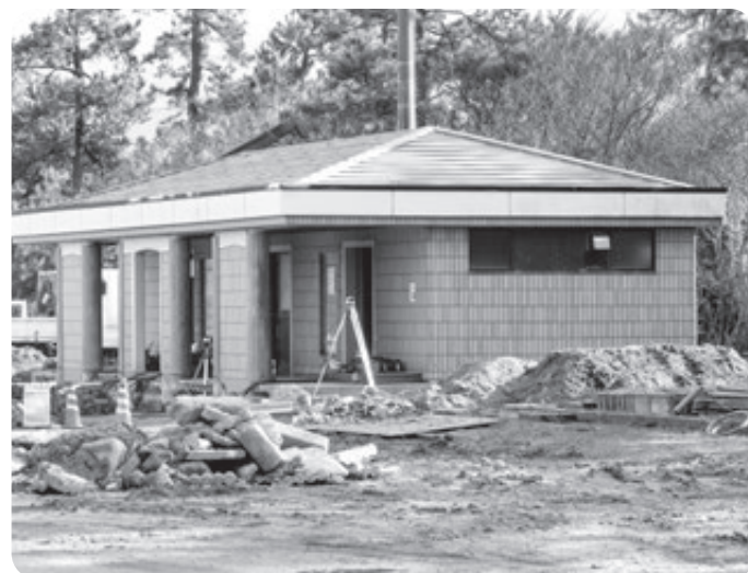
▲沈下した建物をかさ上げ
