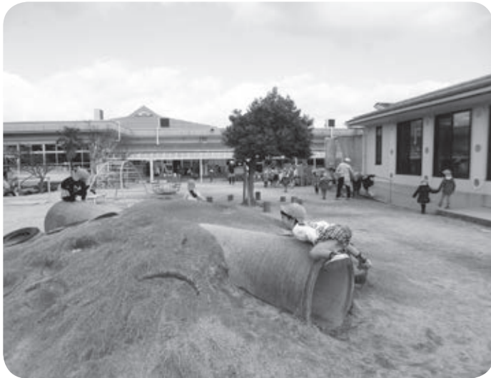
▲解体予定の日吉津保育所
