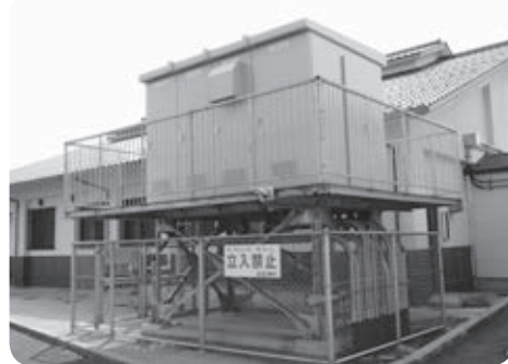
▲福祉センター非常用発電機
