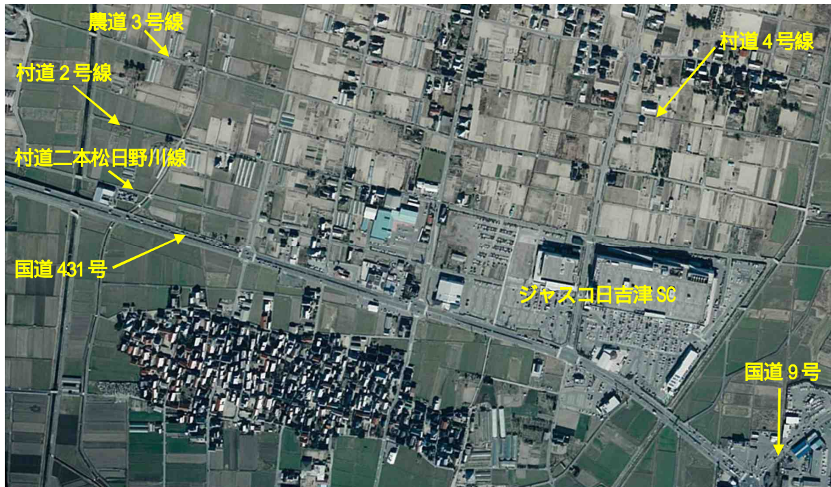
図 -16 国道431号沿道の現況(平成15年2月)
