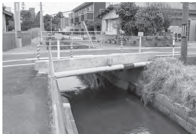
▲村道旧国道線新田川橋
