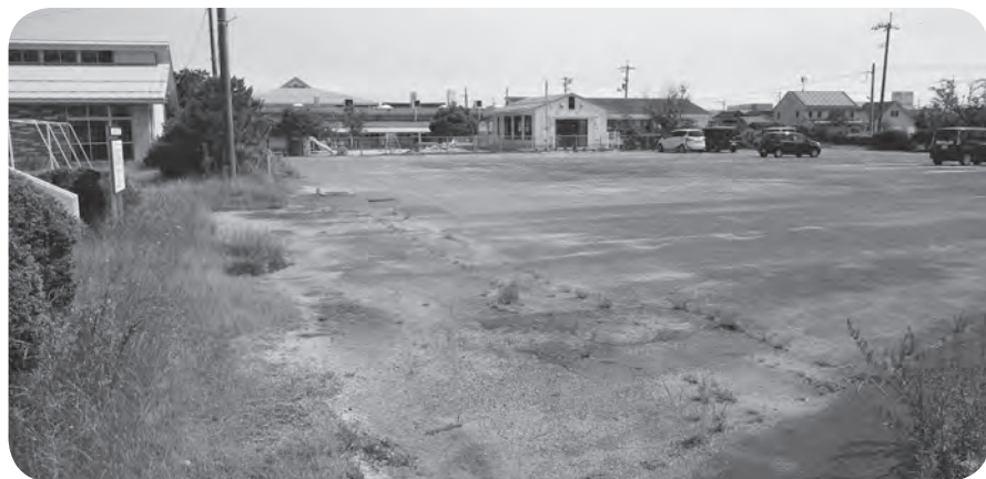
▲複合型子育て拠点施設の工事が始まる敷地
