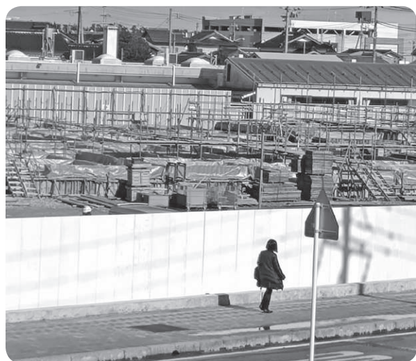
▲移住定住対策にもなる子育て拠点施設(建設中)
