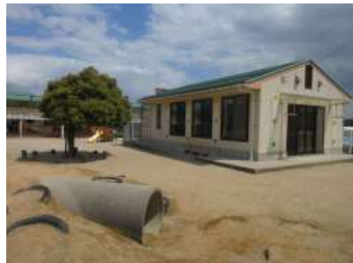
▲増築した保育室(平成22年増築)
