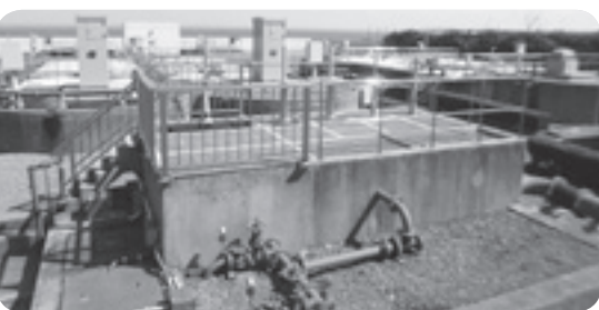
▲修繕が必要な配管
