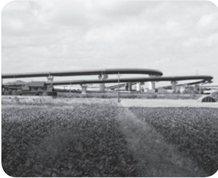
▲米子道インターチェンジ付近
