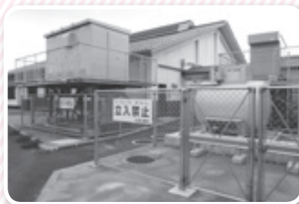
▲非常用発電施設
